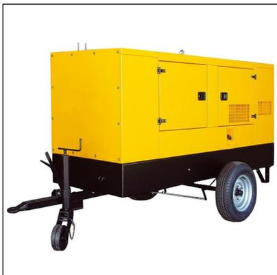
Дизель-генераторные установки **АДГУ-60Я** с дизельным приводом ЯМЗ имеют широкое распространение благодаря многолетней успешной эксплуатации данного оборудования в различных климатических условиях с разными режимами работы.
